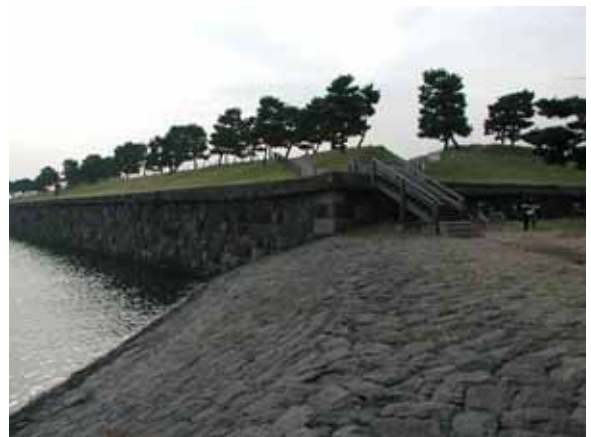
写真-6 第三台場は、開港当時(1941年ころ)の防波堤とつながり、陸続きになっている。写真手前の石積みが防波堤。
