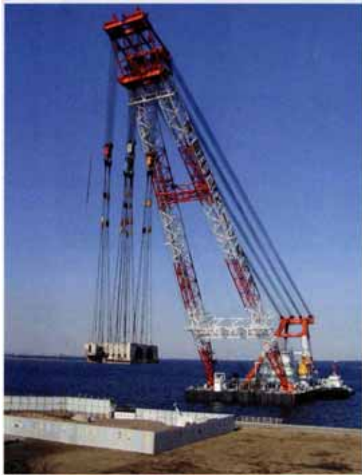
起重機によるうみかぜ公園への移設作業
