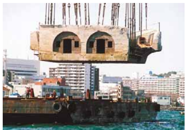
移設に向けクレーン船で釣り上げられる大型兵舎
