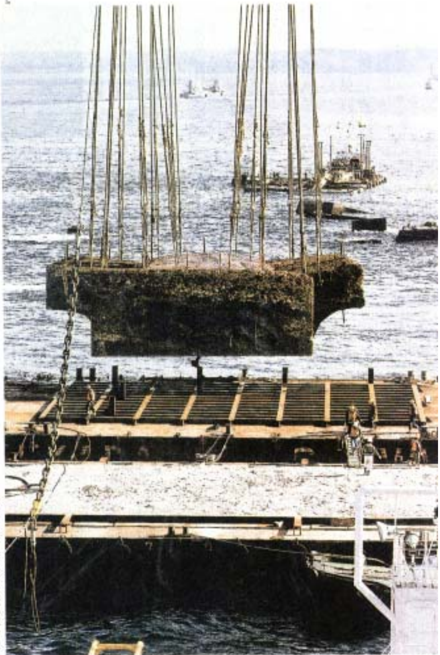
32本のワイヤで海中から引き揚げられる第三海堡の兵舎とみられる巨大構造物—横須賀市走水沖（山田 信次写す）
