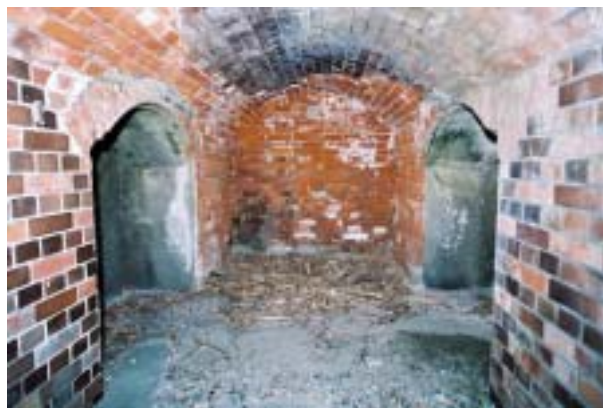
仮弾薬庫内部 2004.3.27 撮影
