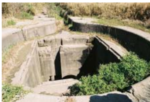
第3砲台電灯井 2004.3.27 撮影
